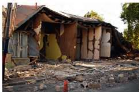
Terremoto de Chile 2010.
